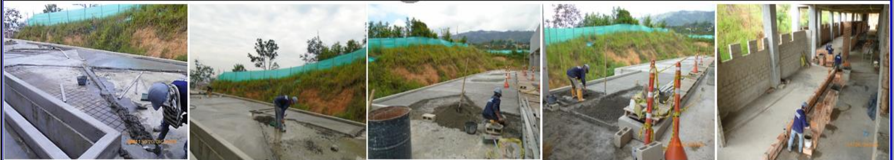
NIVELACIÓN Y ALISTADO DE PISO EN MORTERO PISO 2 EJES: SF4-SF5-SF6-SF7
